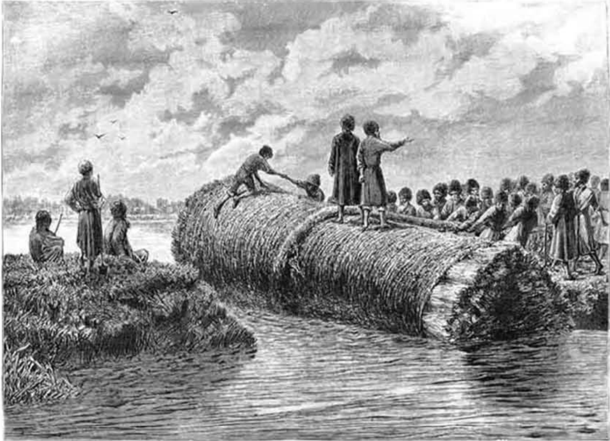
Abb. 5 : Lokale Bewässerungstechnik: Turkmenen bei der Errichtung eines Bewässerungsdamms
