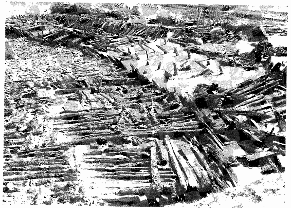
b) Ausgegrabene Reste der Holzkonstruktion der älteren Burg von Behren-Lübchin, Kr. Teterow. 11./12. Jh.
